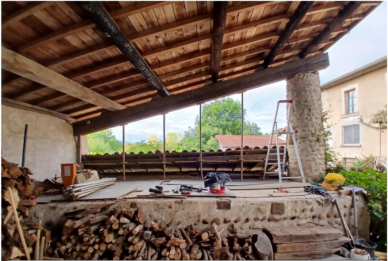
Les montants en cannes pleines supporteront les panneaux et les bambous
