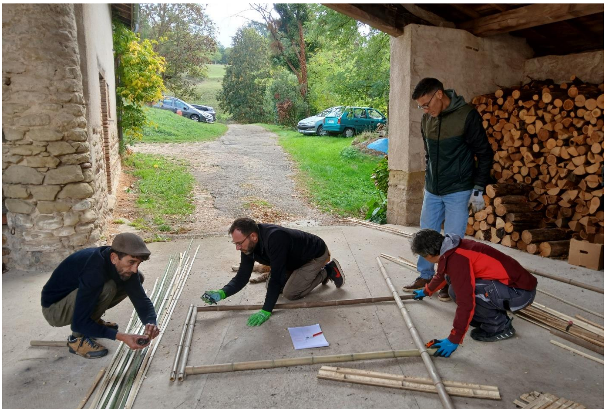
Une équipe construit le cadre pour le tissage de bambous déroulés
